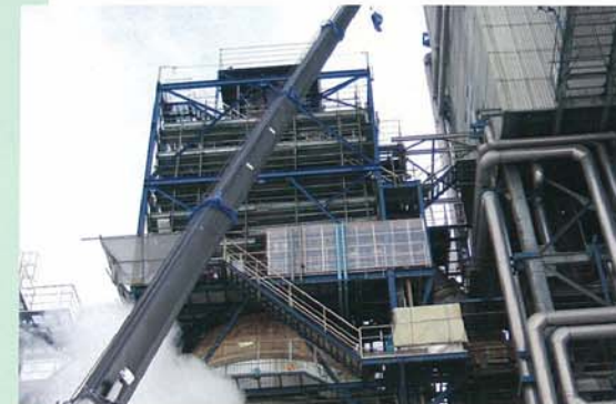
設備改善工事
